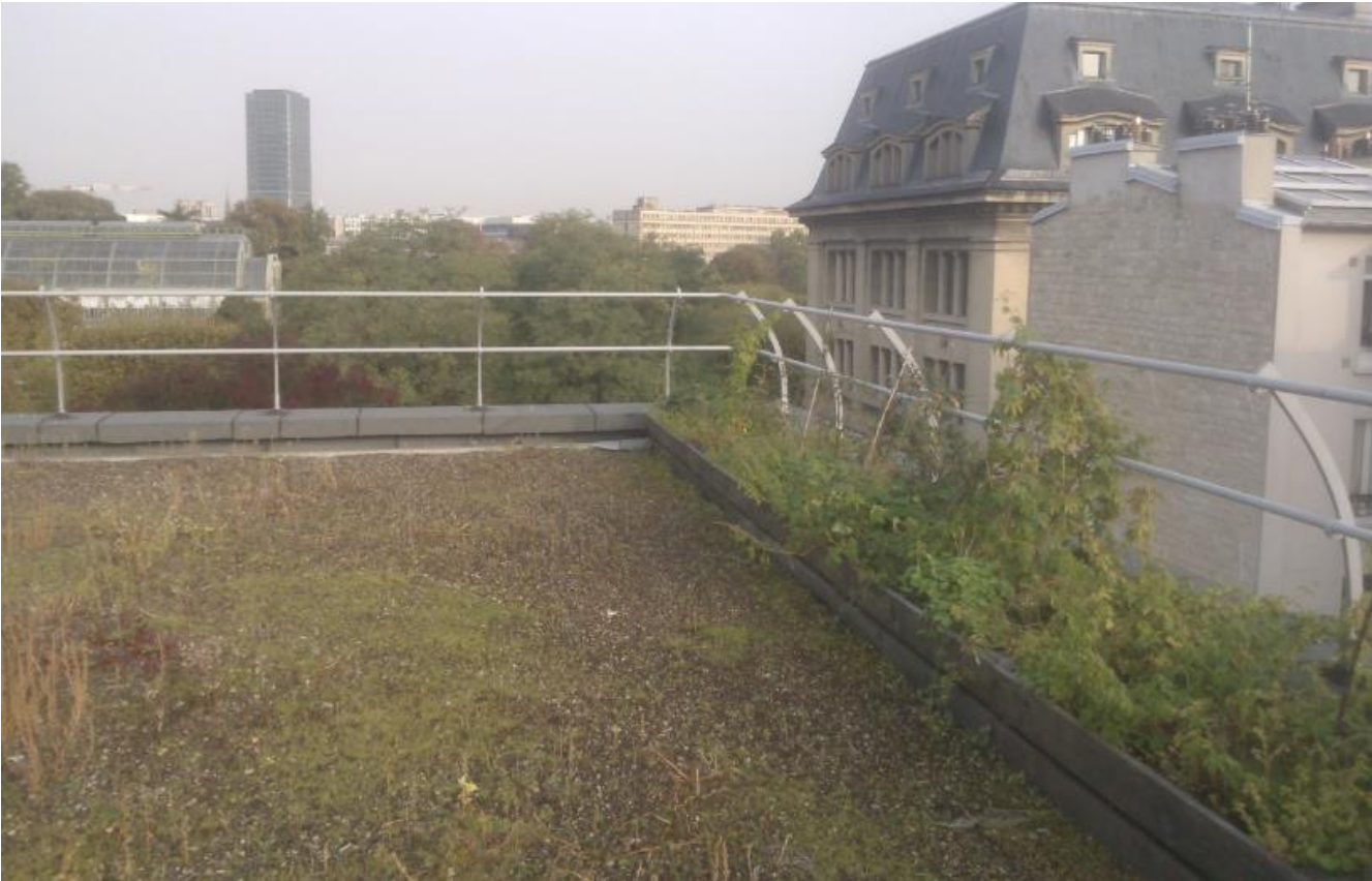
toiture végétalisée du bâtiment d'entomologie, 43 rue Buffon à Paris
